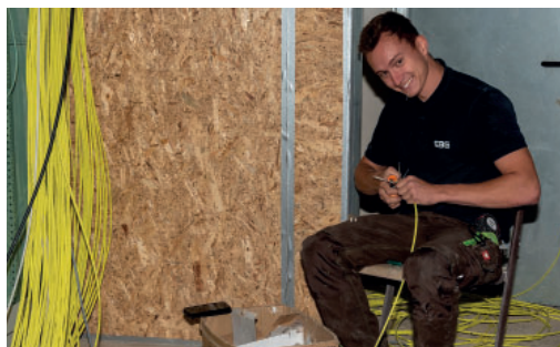
Alexander absolvierte eine Lehre als Elektrotechniker und arbeitete auch bei der Schulsanierung mit.
