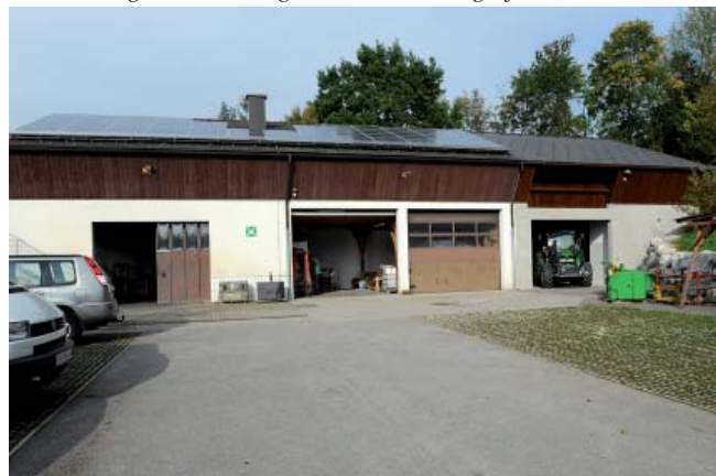
Das bisherige Werkstättengebäude wurde vergrößert
