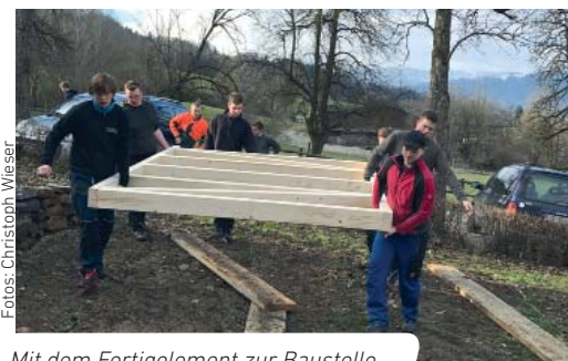
Mit dem Fertigelement zur Baustelle
