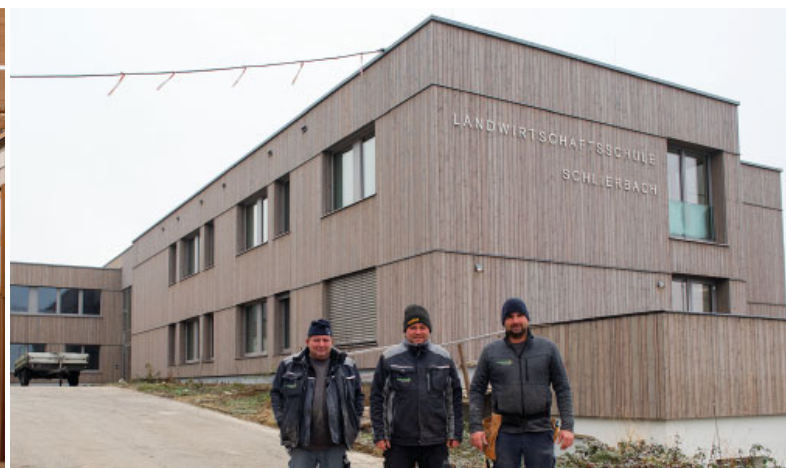
Nach der Montage von ca. 2.500 m 2 Holzfassade verabschiedeten sich Polier Martin Kronsteiner (Fa. Haselsteiner Holzbau) und sein Team am 1. Dez. 2020 von der Baustelle.
